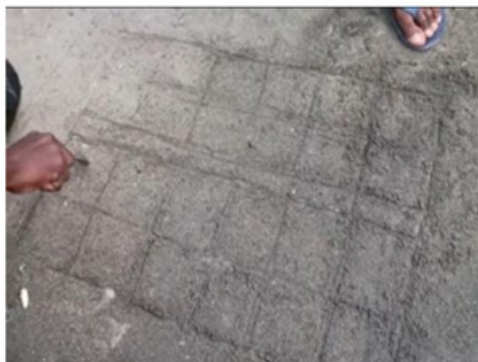
Figura 9 - Marcação das medições para construção
